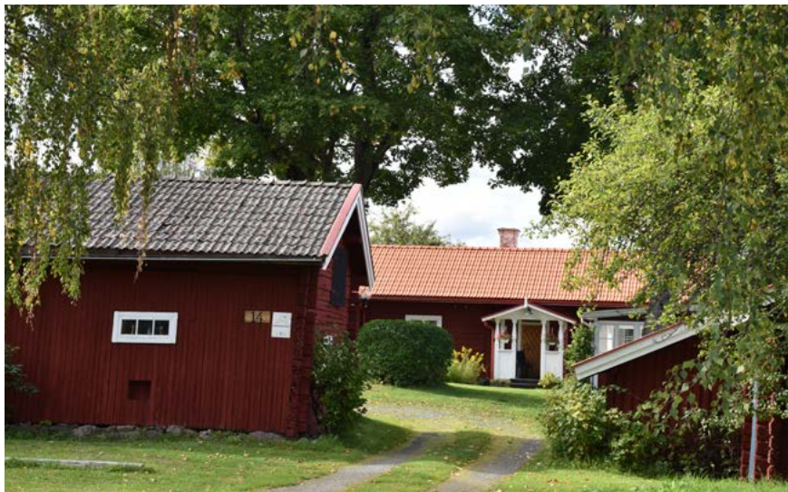
Figur 14: Ovan: den sydligaste av de tre äldsta gårdarna i Tomnäs. Bebyggelsen utgörs av låga timmerbyggnader, grupperade kring ett öppet gårdstun.
