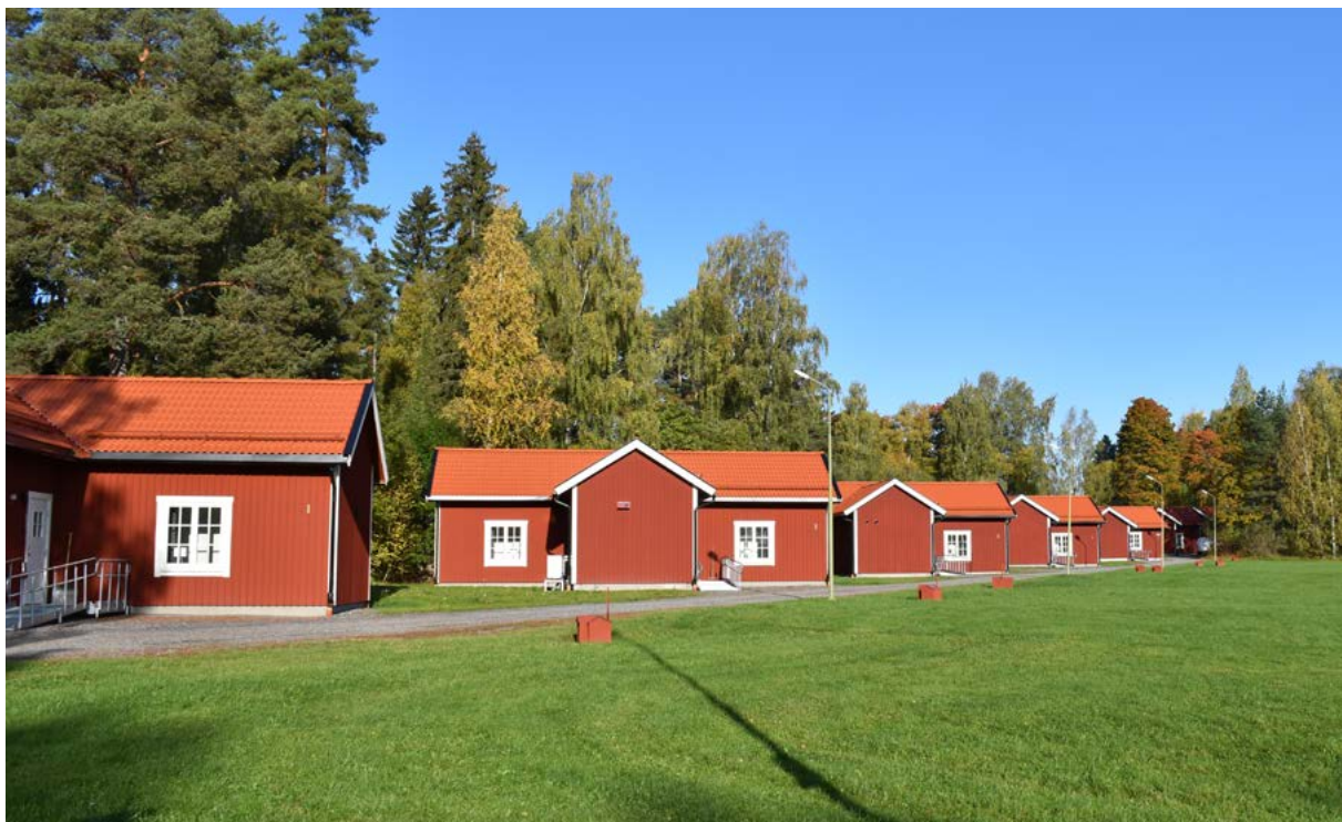
Figur 41: Nya stugor som ersatt de äldre distriktsstugorna. De nya stugorna har givits liknande placering som de tidigare.
