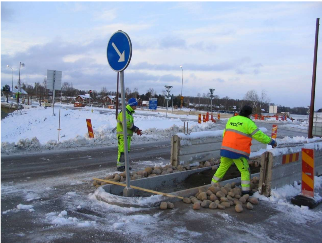
Bild: Slutarbeten anslutningsvägar vid bron inför trafikering.
