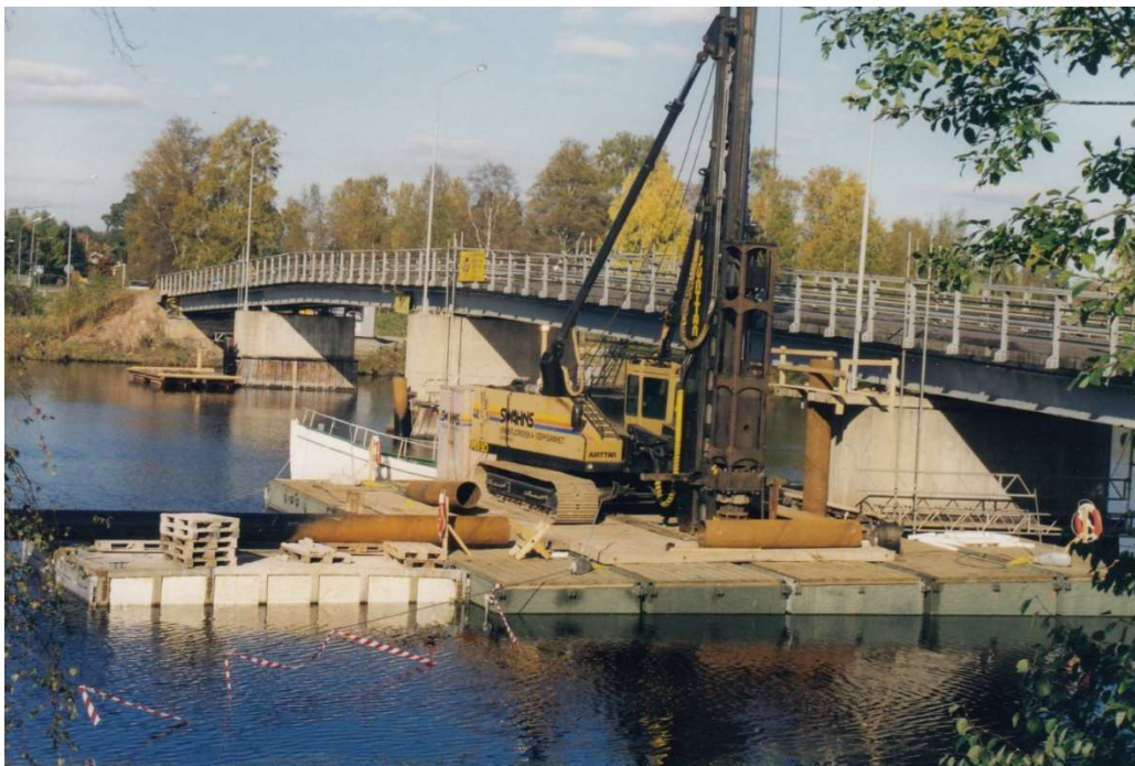
Bild: Bilden visar förstärkningsarbeten 1998.
