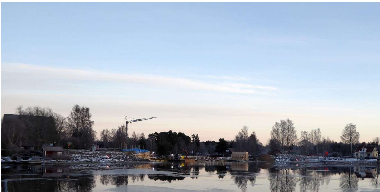
Bild: Formsättning och gjutning av brostöd.
