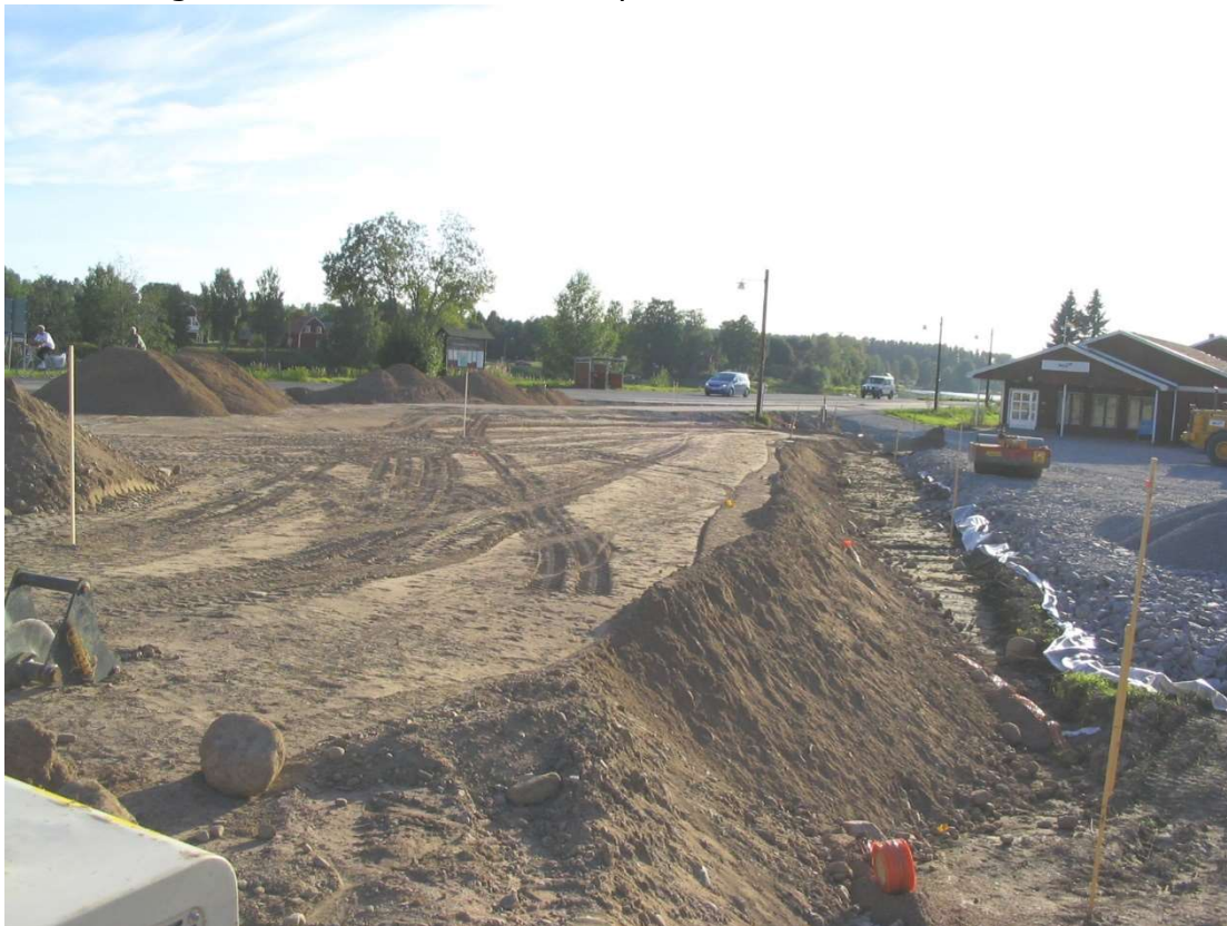
Bild: Första markarbetena med gamla affären i bakgrund som platskontor.
