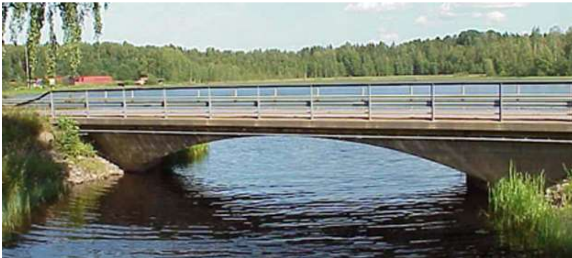
Bild: En bild över bron över flottningskanalen mot Kaplanstjärn 1999.
