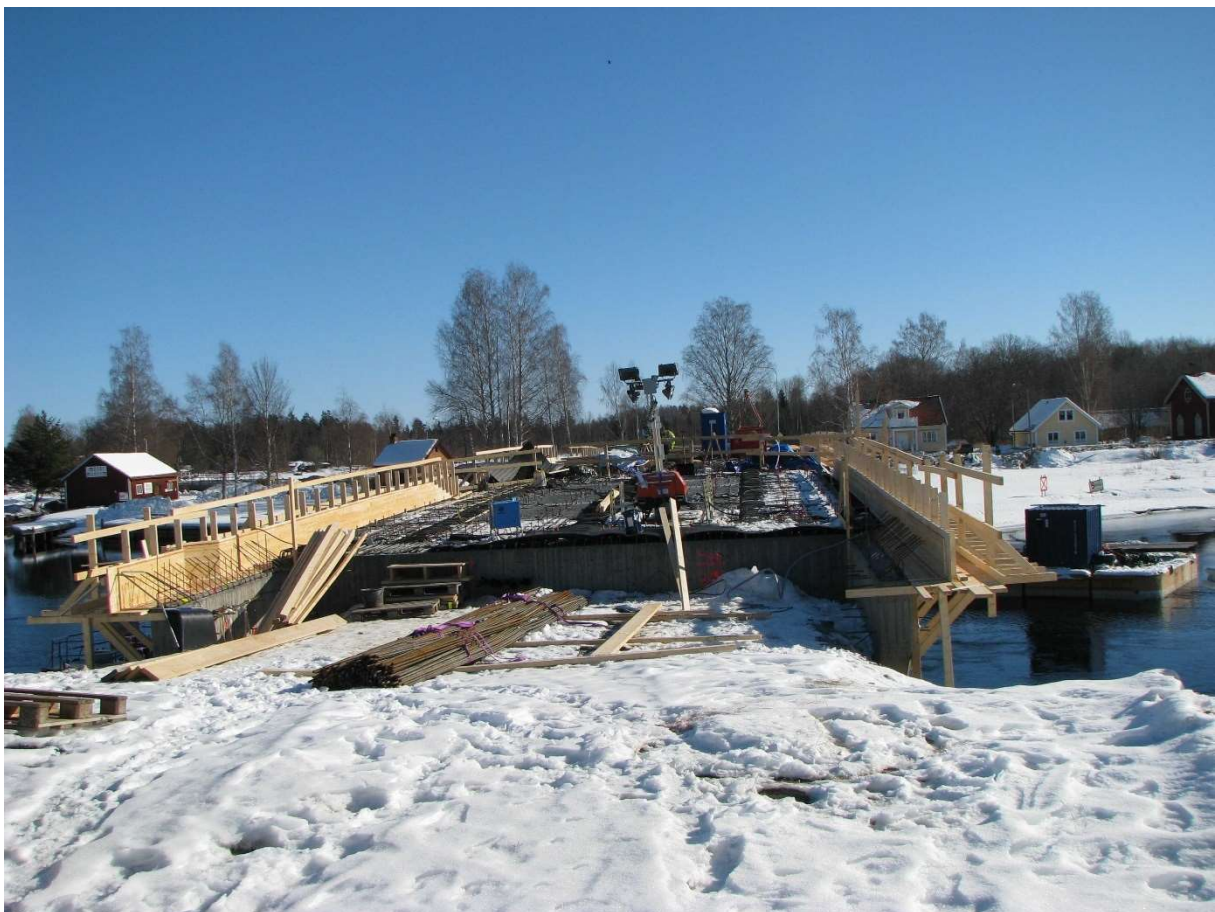
Bild: Formsättning inför gjutning av brobana.
