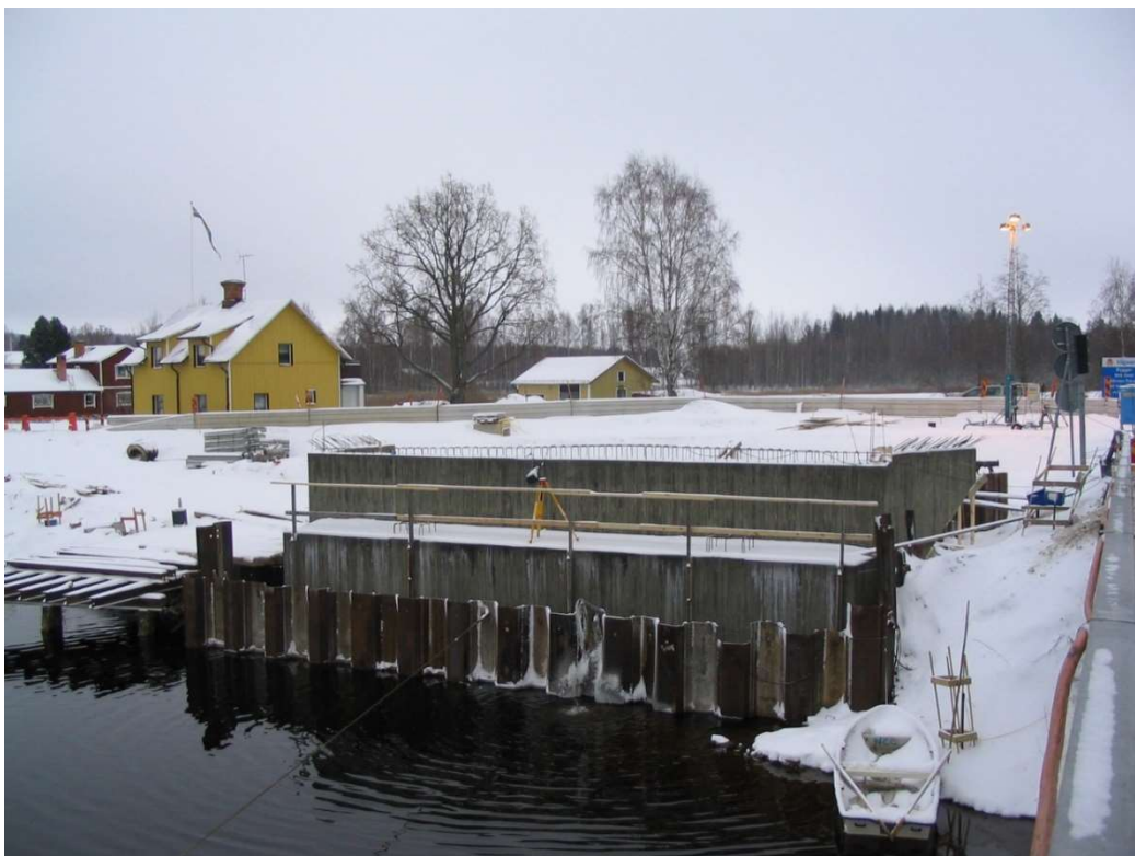
Bild: Gjutning klar av södra landfästet.
