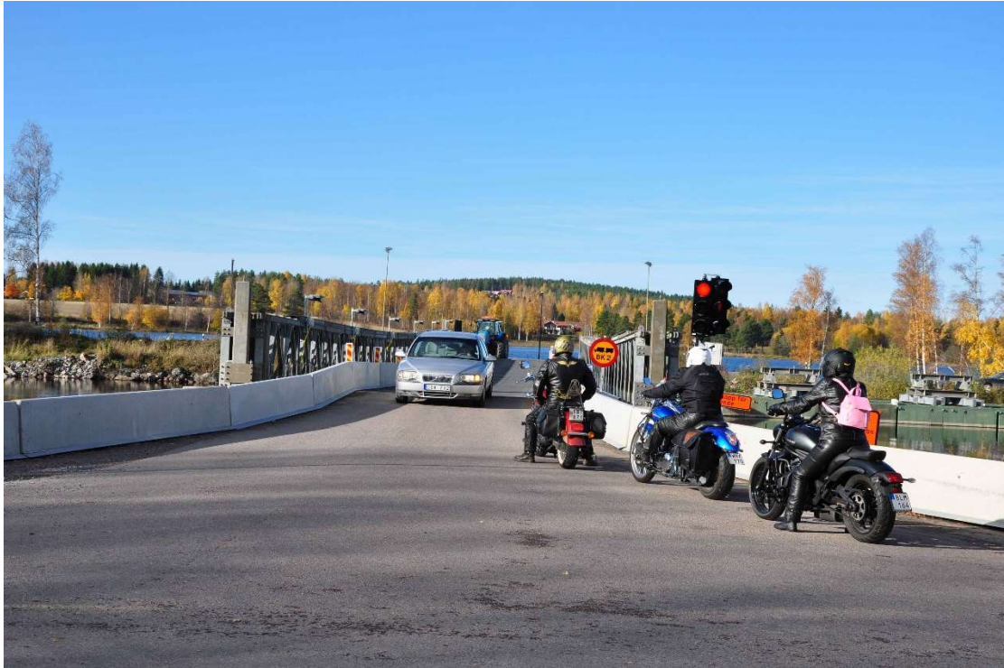
Bild: Bron med trafiksignaler, en bra lösning i väntan på nya broar.
