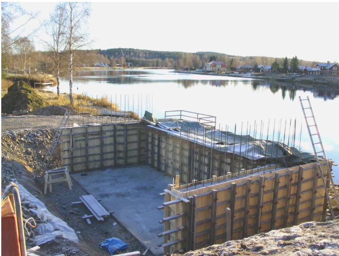
Bild: Gjutning av norra landfästet
