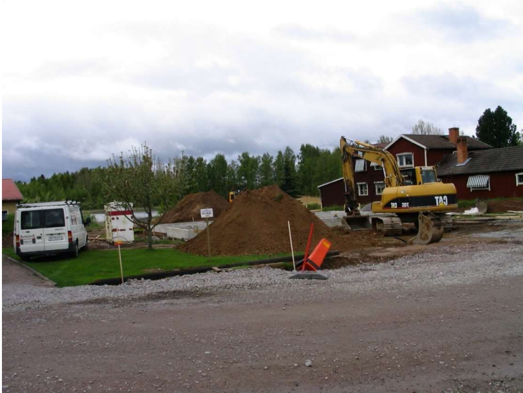
Bild: Ny grundplatta för det nya huset anläggs.
