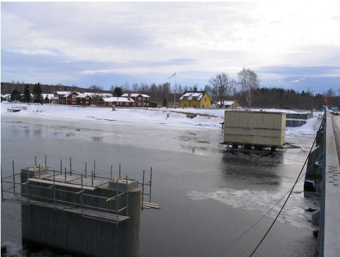
Bild: Brostöden i Dalälven varav det främsta gjutet och gjutform på det bortre.
