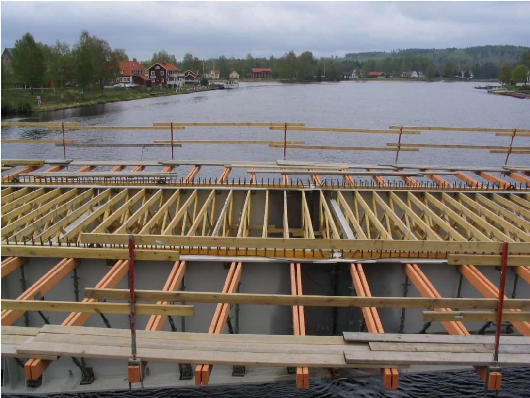
Bild: Iordningställande formsättning för gjutning av brobana 2006.
