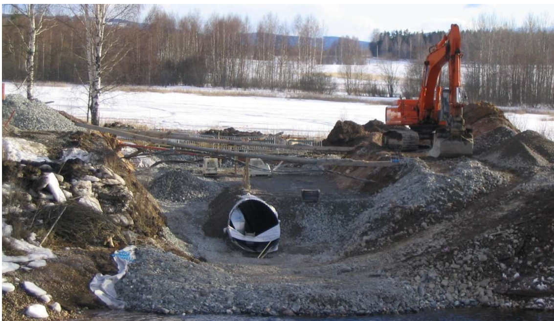
Bild: Ny vägtrumma läggs mellan Kålsjön och Dalälven 2006.
