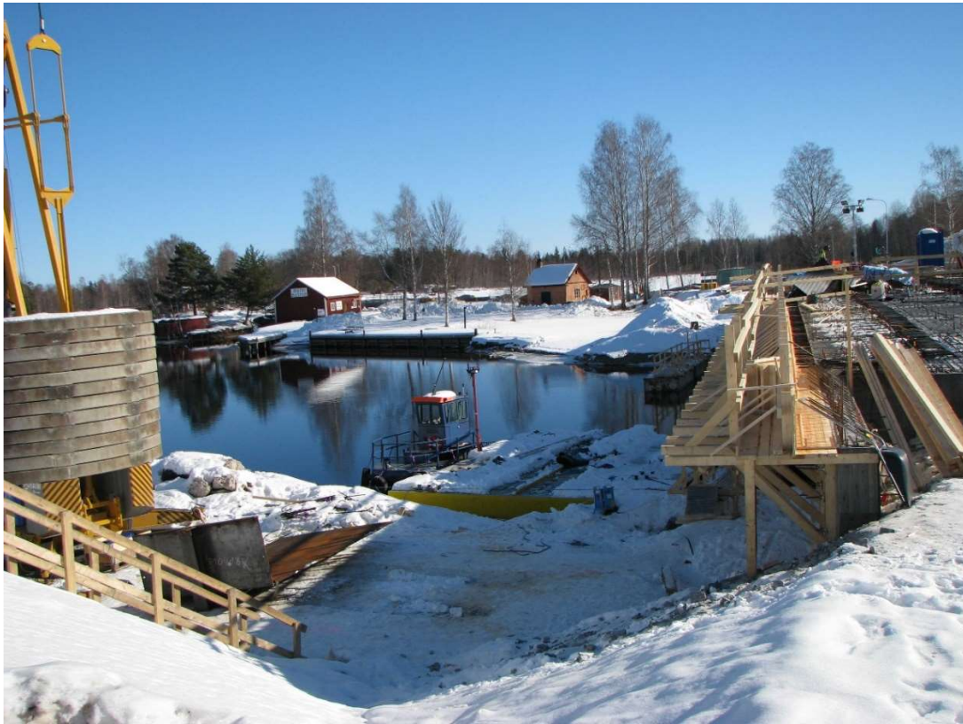
Bild: Formsättning inför gjutning av kantbalk
