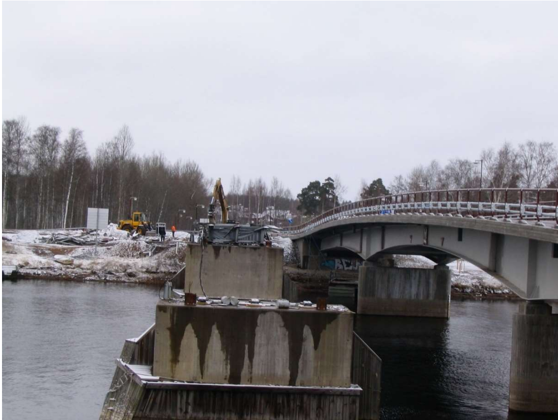
Bild: Rivning av gamla fasta bron påbörjad.
