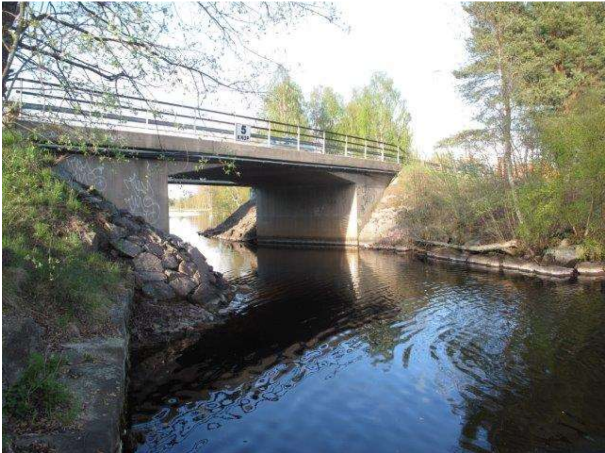
Bild: Nuvarande kanalbro Foto från Trafikverket "Batman"
