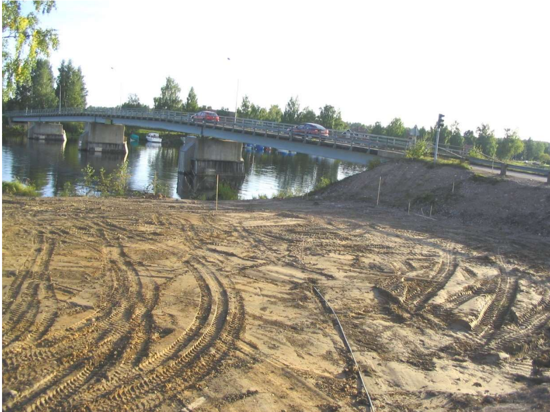
Bild: Fortsatta markförberedelser vid norra landfästet.
