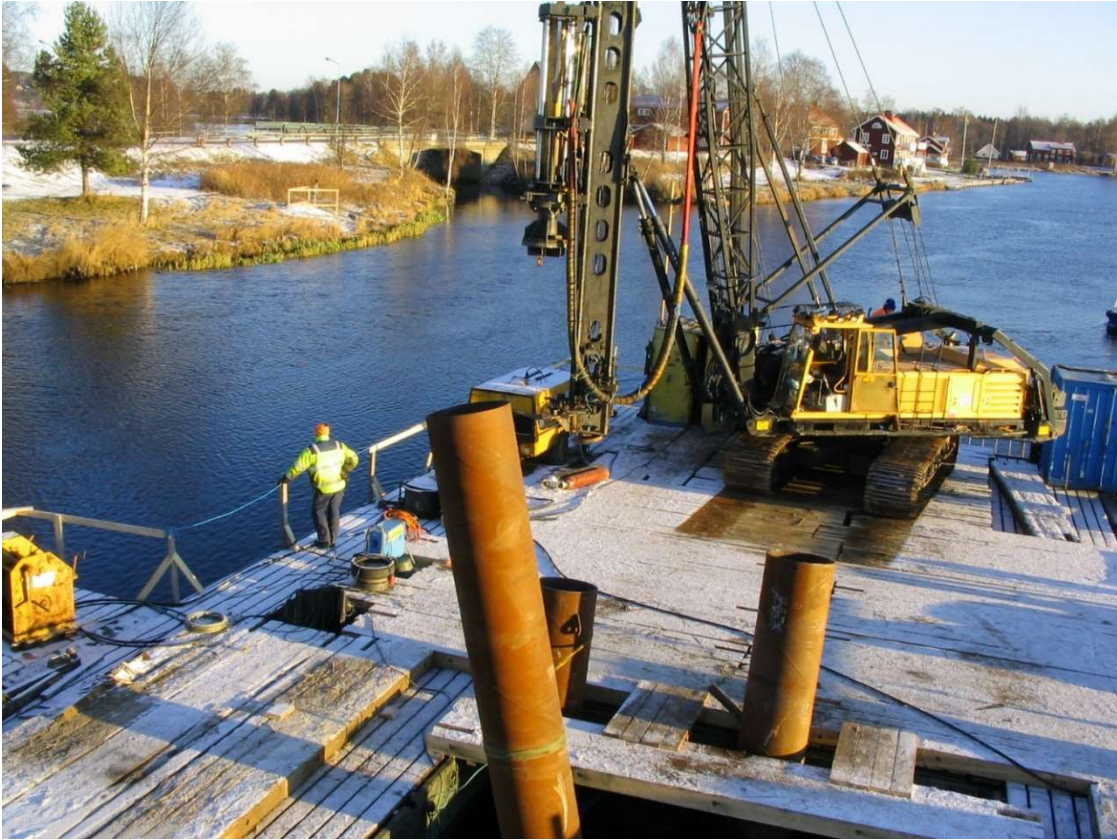
Bild: Pålningsarbeten för brostöden i Dalälven.
