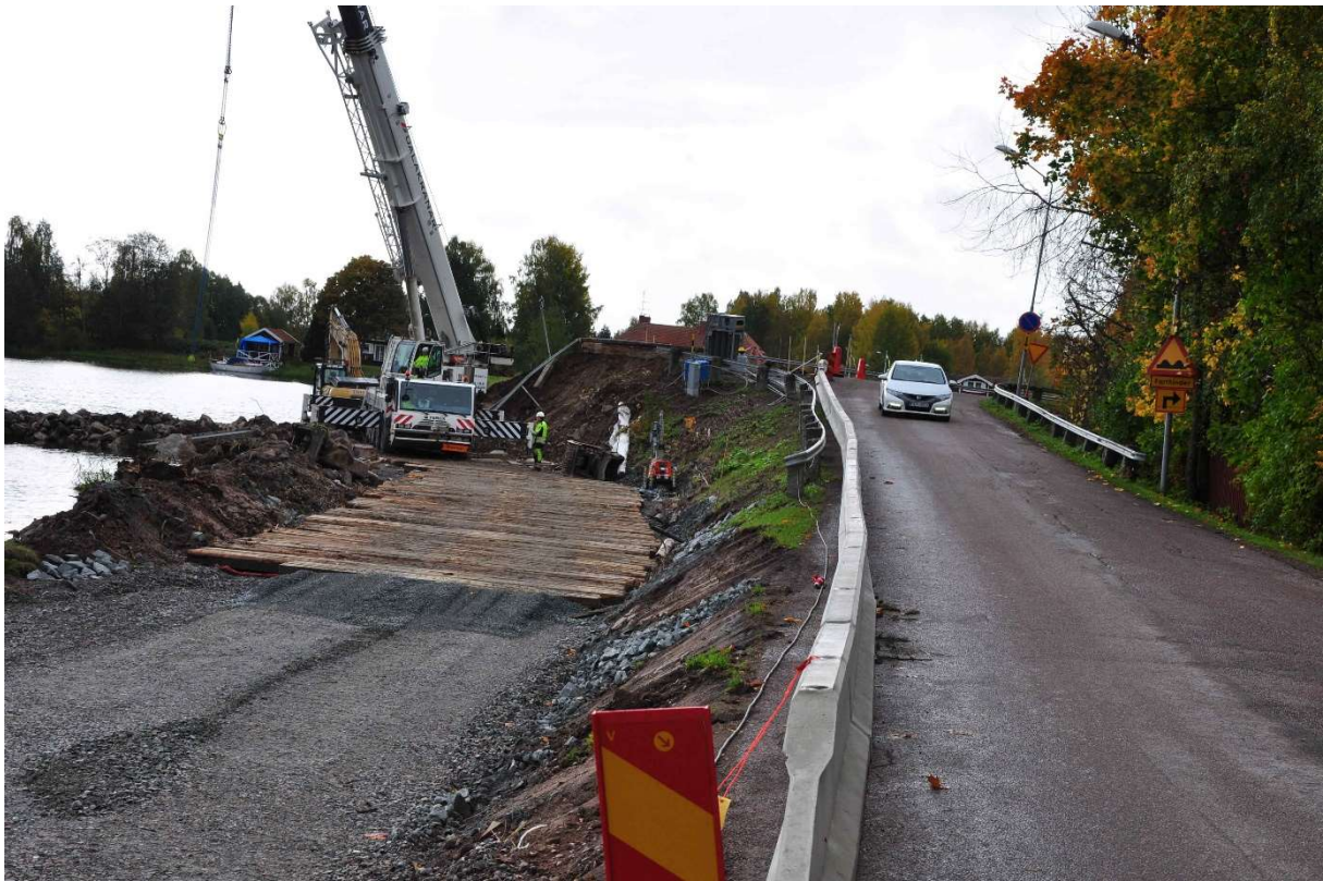
Bild: När den gamla bron rivits påbörjas arbetet med att grundlägga den nya bron hösten 2016.
