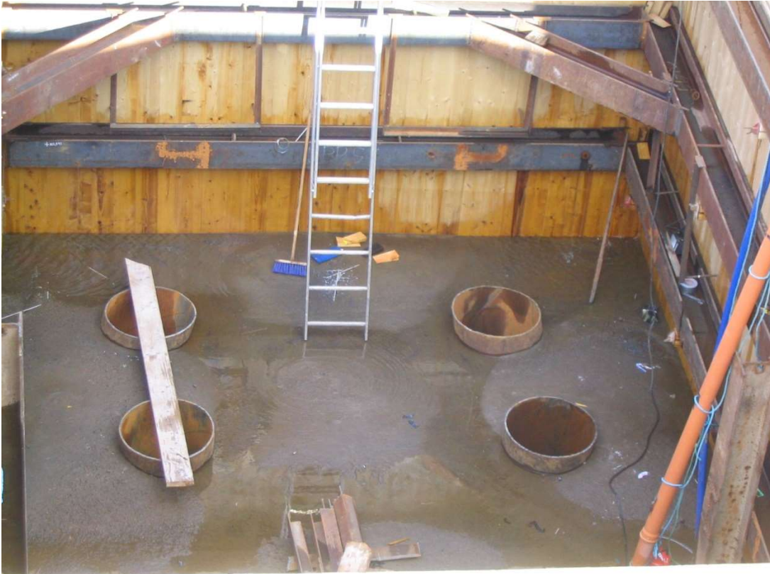
Bild: Gjutform över pålar för brostöd i Dalälven.
