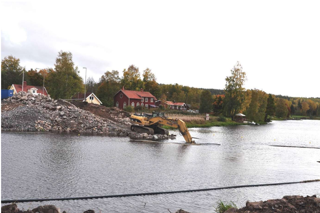
Bild: Rensning inför Grundläggning och pålning
