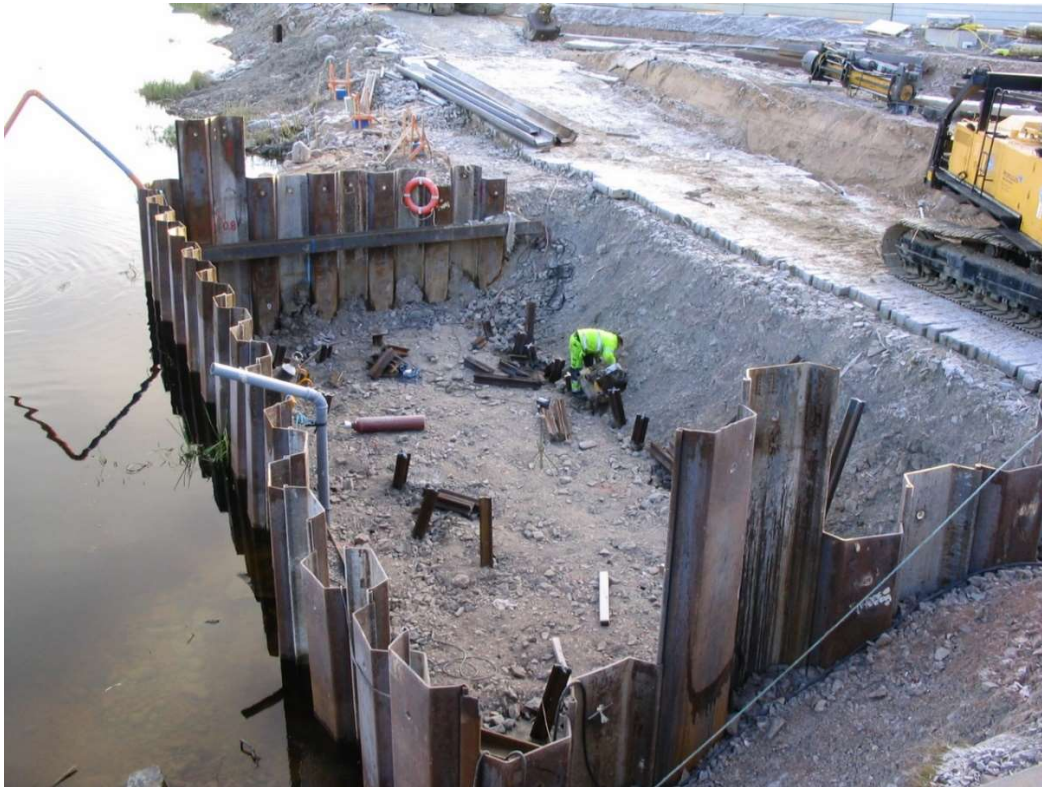
Bild: Spåntning och förberedelser gjutform södra landfästet, Tyllasidan.
