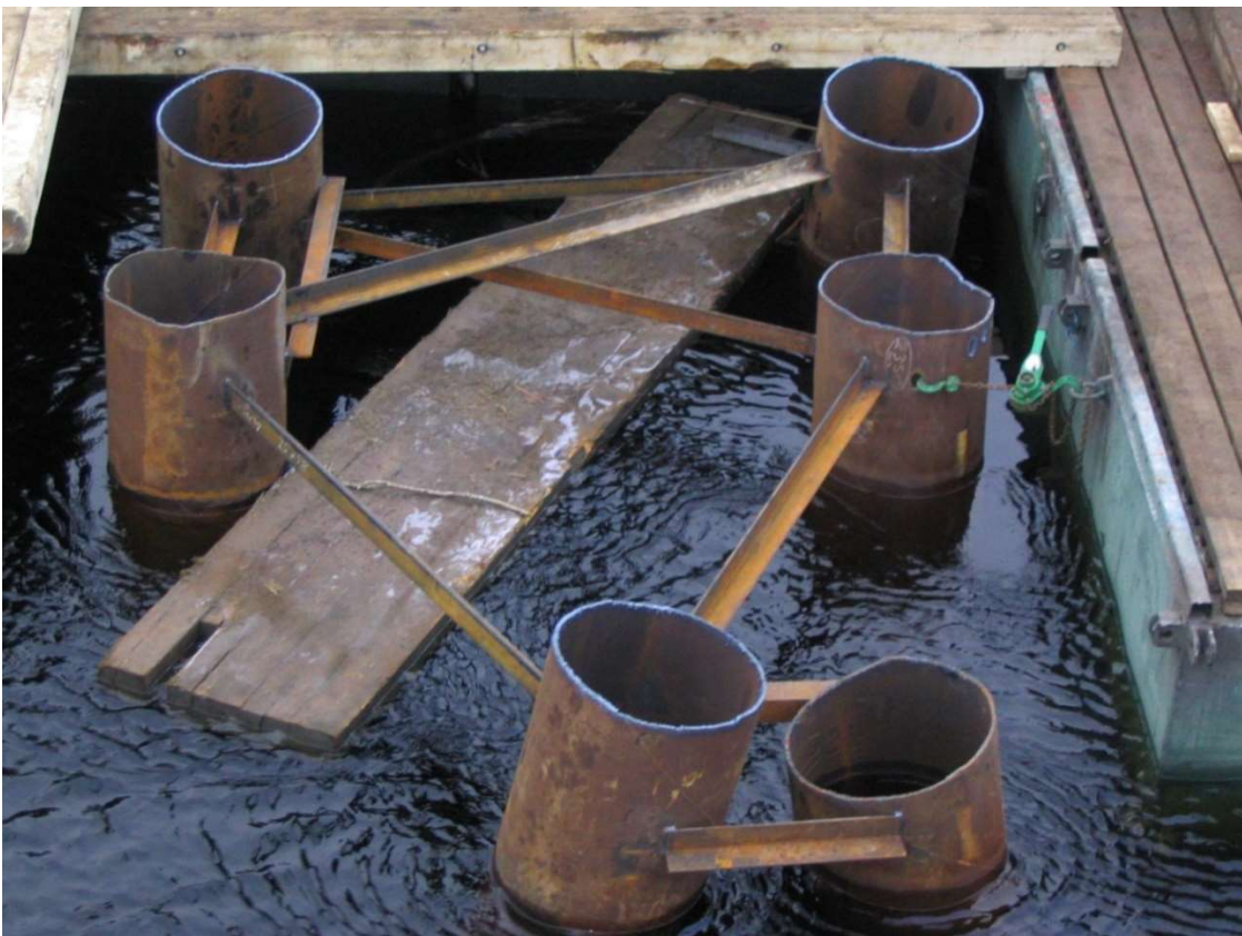
Bild: Rörpålar i grupp för brostöd i Dalälven.
