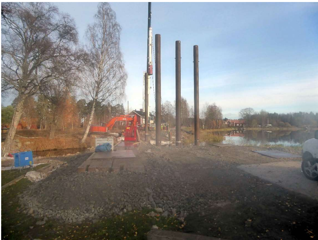
Bild: Grundsättning med pålning en dimmig höstdag.
