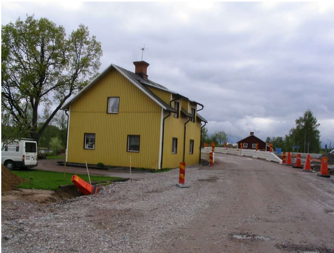
Bild: Gula huset på Tyllasidan strax innan rivning.
