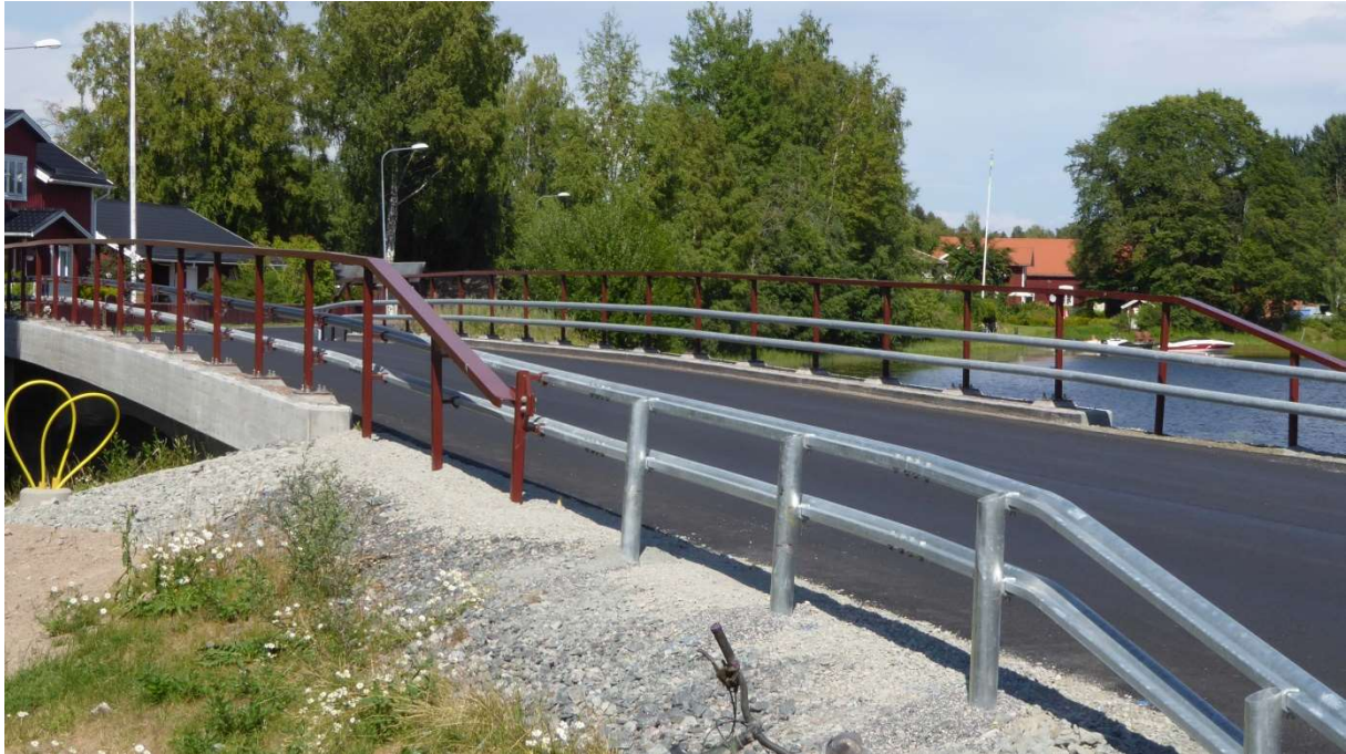
Bild: Nya bron med räcketkonstruktion
