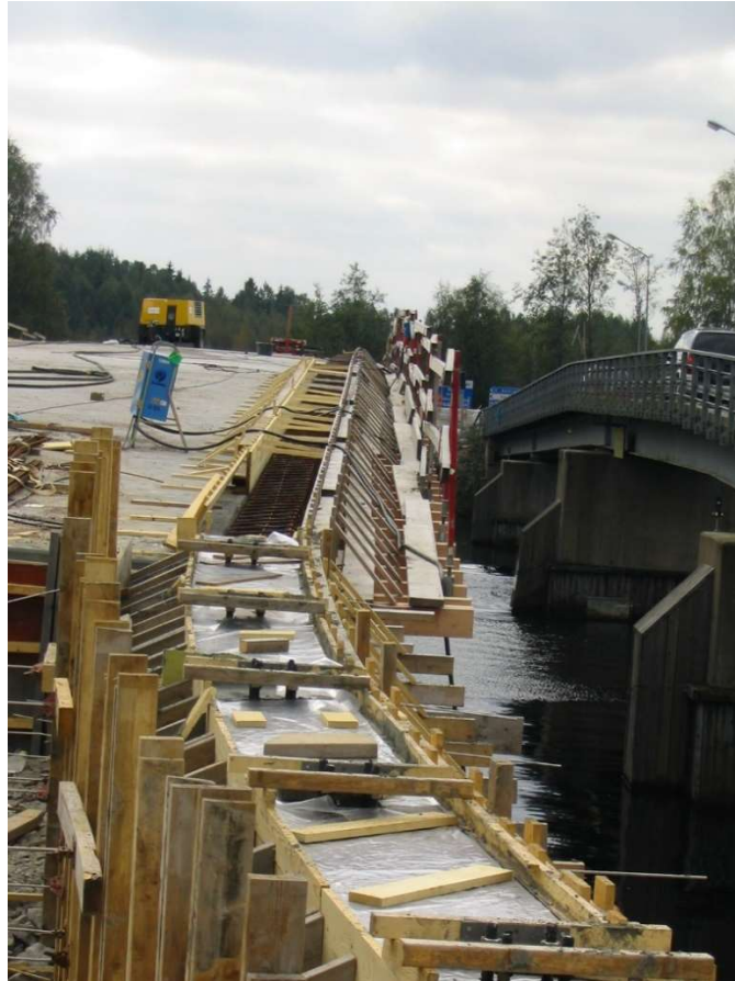
Bild: Kantbalk vid brobana, gjutning påbörjad.
