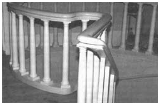
Invändig trapp i "Lidmans" gamla fastighet på Sunnanö. Enligt muntlig tradition är Johan Görsson upphovsman till arbetet omkring 1840-talet.
