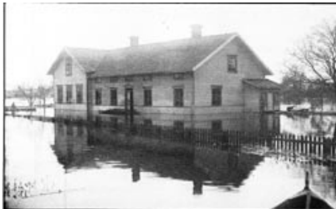
Här synes skolhuset under vårfloden 1916. Vyen tagen aftonen den 15 maj. Vattnet 1 dm högre den 16:e på e m. Cirka 1 dm högt vatten i skolsalen, ännu djupare i Branders rum. Skoltrappan har flytit upp men av brovaktaren Nyman fastslagits med kettingar. Planket i nedre hörnet översvämmat. Mannen i ekan är brevbäraren Pettersson. På flotten utanför Branders dörr sitter Pajo och är ledsen. (Till John Thelin från föräldrarna)
